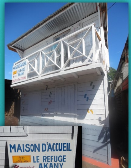
Construction d'une maison d'accueil
